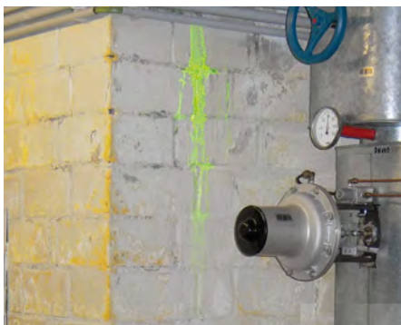
Localización de conductos de agua con salideros en edificios mediante la introducción de uranina y la inspección UV.
